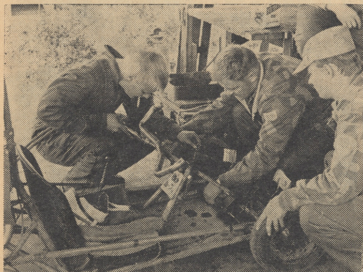
Hyväkin auto tarvitsee huolenpitoa. Tässä vahvistellaan hitsamalla jotakin ohjauslaitteisiin kuuluvaa hilavatkulaa.
